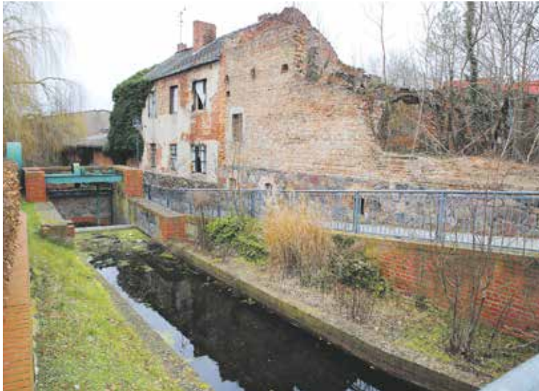
Das Helios-Areal bietet einen trostlosen Anblick. Jetzt erfolgen Sicherungsmaßnahmen, damit der Weg wieder freigegeben werden kann. FOTO: MARCEL GÄDING
