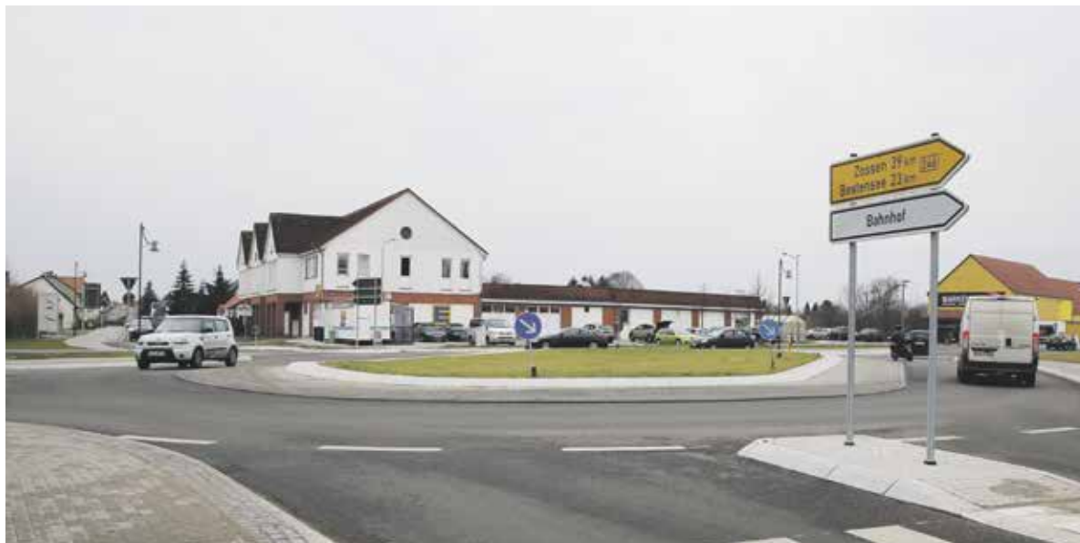
Der Kreisverkehrsplatz an der Bundesstraße 246: Derzeit „schmückt“ eine unscheinbare Wiese die Mitte. Das soll sich in diesem Jahr ändern. FOTOS: MARCEL GÄDING
