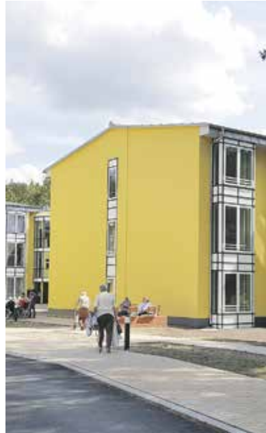
Modern ist der Ersatzneubau, der 20 Bewohnern nun ein neues Lebensumfeld bietet. FOTO: ALTENPFLEGEHEIM
