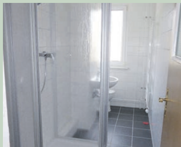
Ein Bad im Wohnhaus in der Theodor-Fontane-Straße nach dem Einbau einer Dusche.
