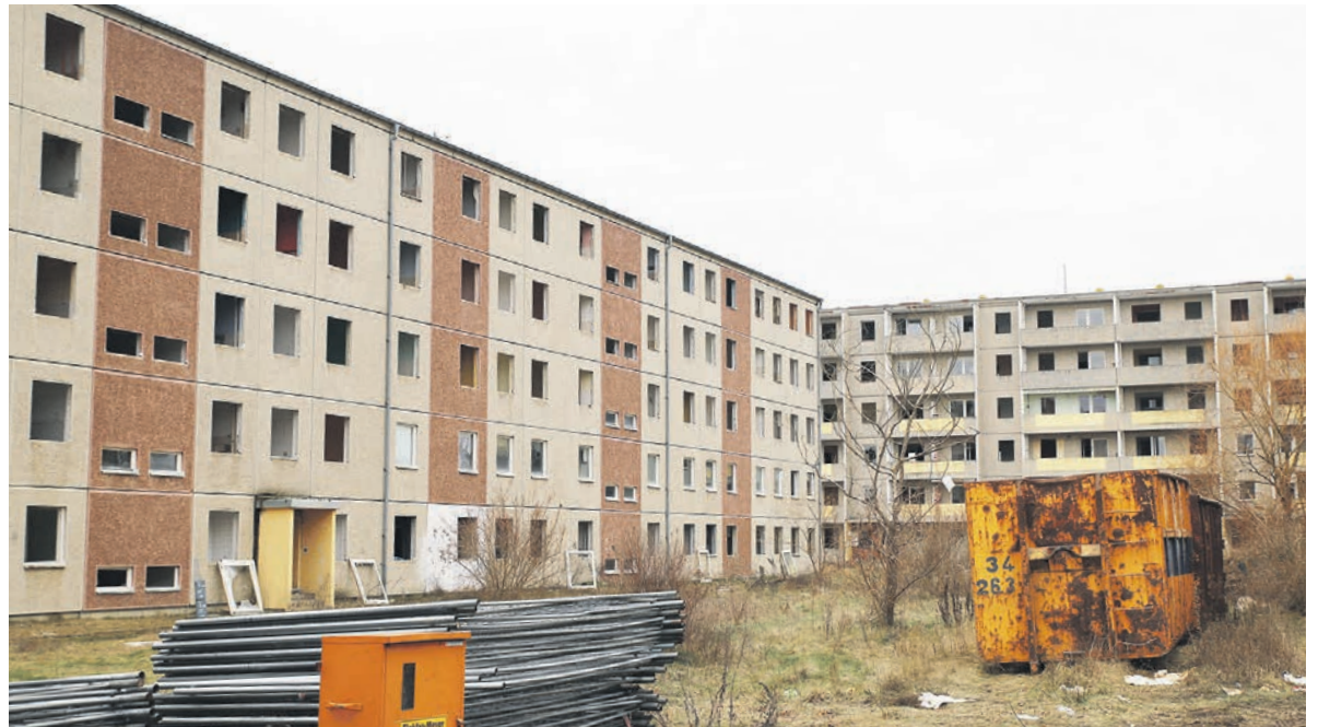
Die Plattenbauten – hier eine Aufnahme vom Januar 2018 – stellten viele Jahre ein Ärgernis dar. Erst im vergangenen Jahr brannte es in einer der Wohnungen.
