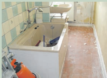
Bad in der Theodor-Fontane-Straße vor dem altersgerechten Umbau.
