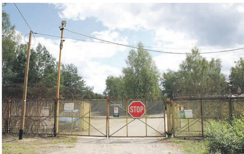
Die Einfahrt zum Firmengelände ist deutlich in die Jahre gekommen. Davor verlaufen alte Bahngleise. FOTO: MARCEL GÄDING
