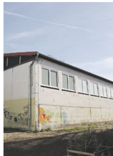
Die Fenster sind bereits erneuert, nun soll noch die Fassade der Sporthalle saniert werden. FOTO: MARCEL GÄDING
