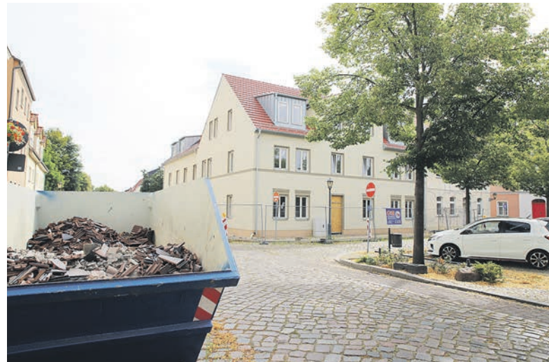
Architektonisch fügt sich der Neubau von Investor Rainer Opolka (Foto links) gut in die Gegend um den Marktplatz ein. Die Ruine des Helios-Geländes (kleines Foto) soll abgerissen werden.
