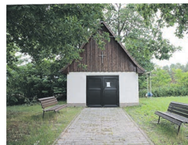
Die Trauerhalle von Schwerin ist derzeit gesperrt.
