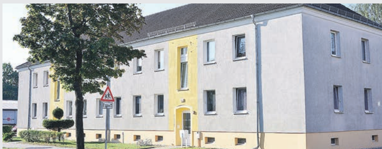
Die WBG-Häuser in der Karl-Marx-Straße bekommen eine neue Fassade.
