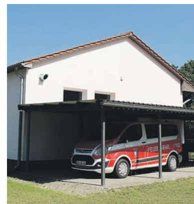
Das Mannschaftstransport ist derzeit provisorisch unter einem Carport neben der Fahrzeughalle untergebracht.
