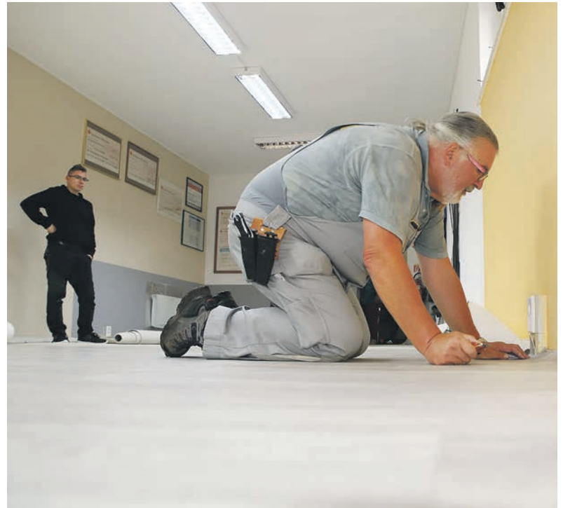
Der gelernte Raumausstatter Roland Riedinger verlegte ehrenamtlich den neuen Fußboden bei der Storkower Tafel. FOTO: MARCEL GÄDING
