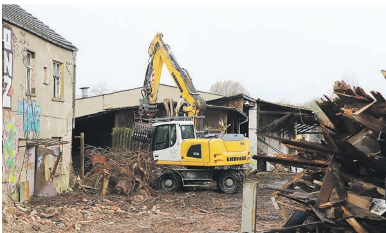
Schweres Gerät beseitigt Wildwuchs auf dem Helios-Gelände.
