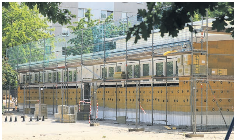
Derzeit wird die Turnhalle des Horthauses saniert. Dort wäre Platz für Solarmodule.
