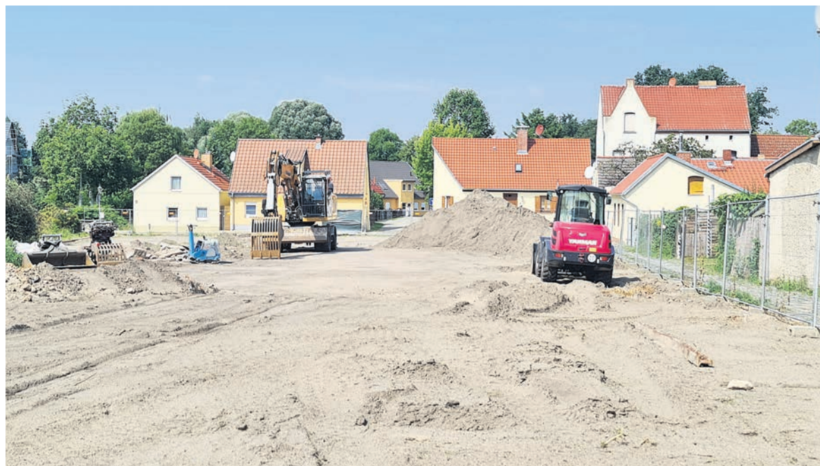
Wie eine Mondlandschaft wirkt das Helios-Areal, auf dem sich bis zum Frühjahr noch Gebäude und Ruinen befanden.
