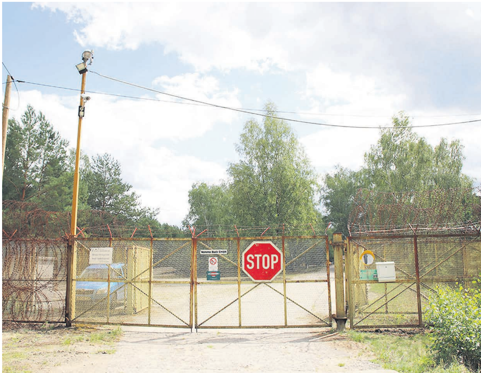
Nahe Bugk soll eine Munitionszerlegungsanlage genehmigt werden. Dort existiert bereits eine Einrichtung des Antragstellers.
