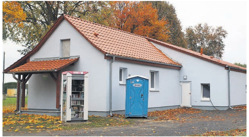
Auch die Fassade des Sportgebäudes in Alt Stahnsdorf wurde saniert.
