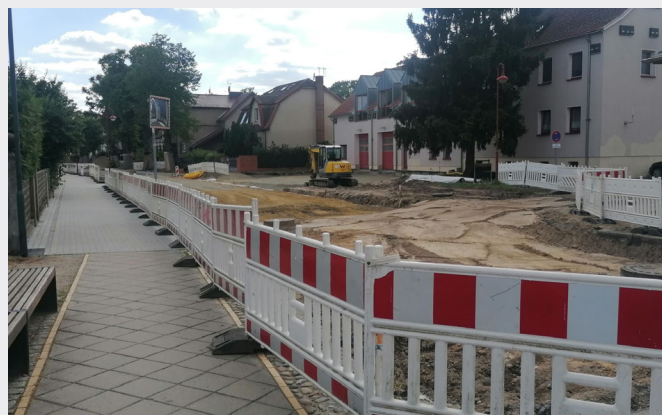
Die Sanierung der Gerichtstraße ist bald abgeschlossen. FOTO: ZIEMER
