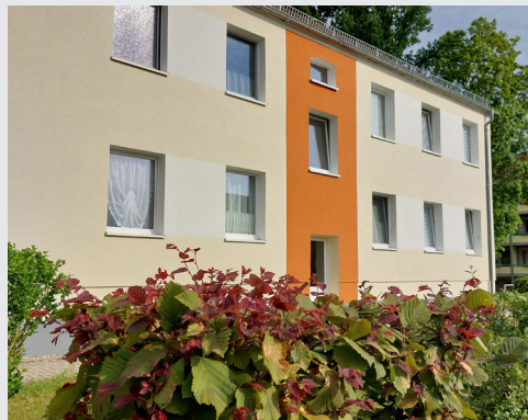
Neuer Farbe, Fenster und Türen gab es für das Haus in der Theodor-Fontane-Straße 29. FOTO: STORKOWER WBG
