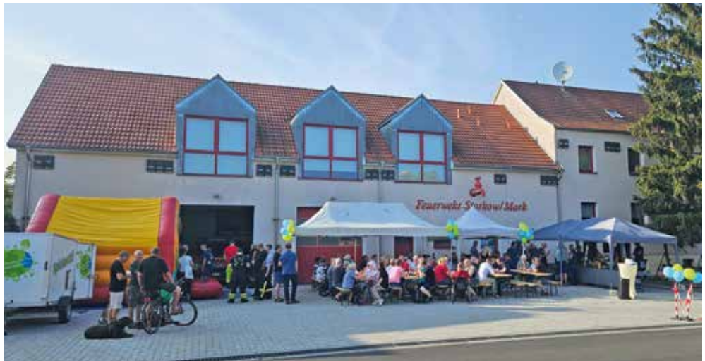
Auch der Platz vor der Feuerwehr wurde saniert. Er diente gleich als Festplatz
