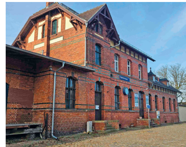
Das Bahnhofsumfeld soll attraktiver gestaltet werden. FOTO: ZIEMER
