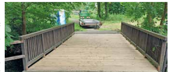
Der Belag der Holzbrücke in Kummersdorf wurde erneuert. FOTO: SVS
