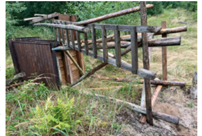
Mehrere Hochstände wurden im August zerstört. FOTO: SVEN DROGAN
